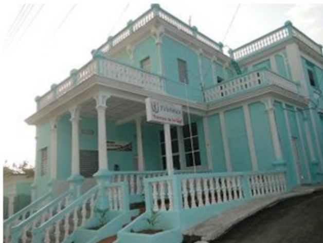
Figura 9. Policlínico Francisco del Sol después de la reinauguración.
