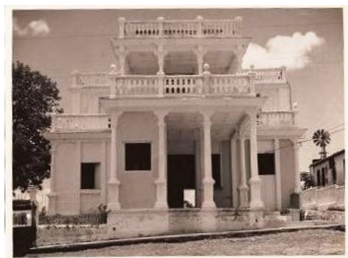
Figura 3. Edificio en el que queda instalado el policlínico Francisco del Sol.
