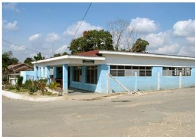
Figura 8. Centro de Rehabilitación de San Fernando de Camarones.
