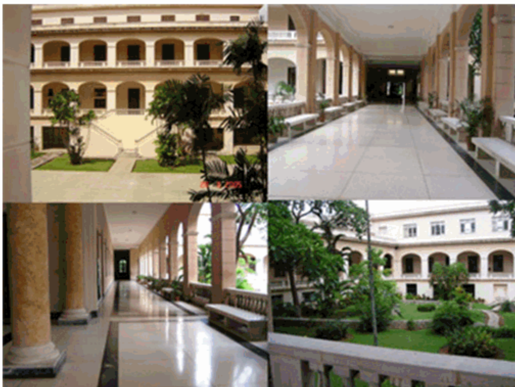
Vistas interiores del Instituto de Ciencias Básicas y Preclínicas Victoria de Girón.
